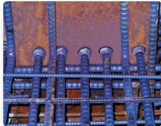
▶ 용접용 커플러 시공
